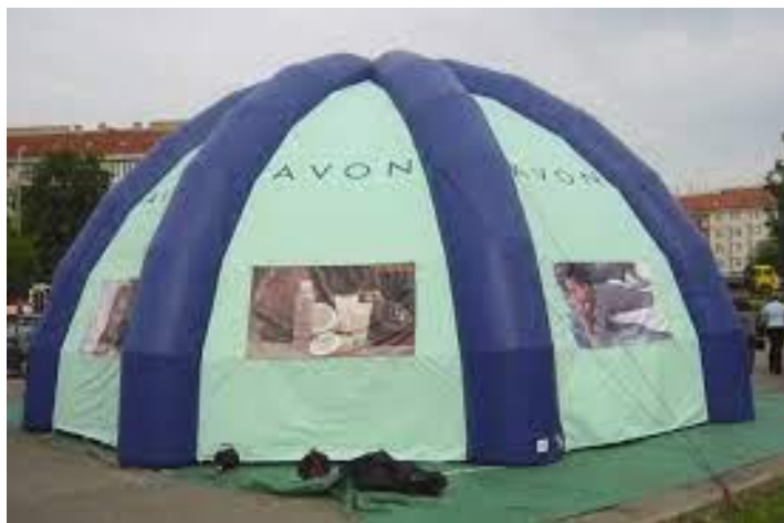
Obrázek č. 28 – Vysokotlaká pneumatická střecha - oblouky
