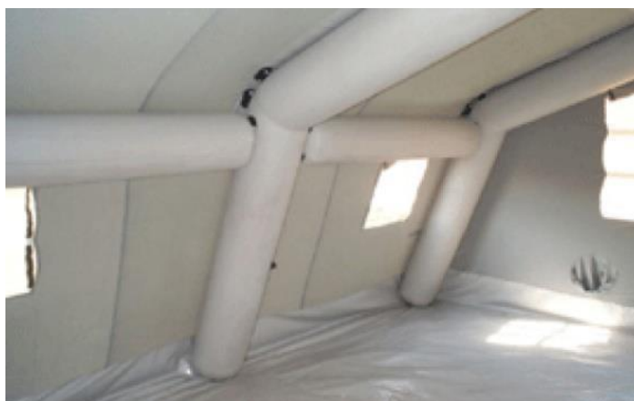
Obrázek č. 26 – Vysokotlaká pneumatická střecha - žebra [3]
